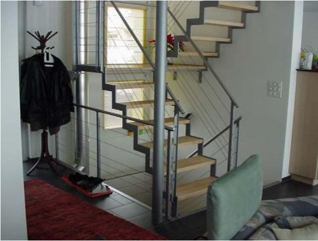
Mit Metall lassen sich sehr filigrane und moderne Treppen für Innen oder Aussen realisieren.
